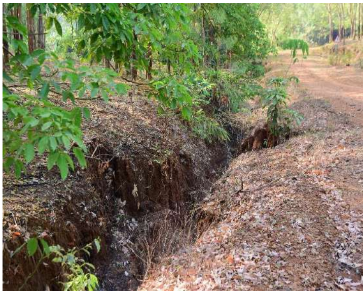
Hình 24. Xói mòn rãnh tại lô 7.8a KH
